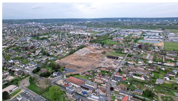
La friche après les travaux
