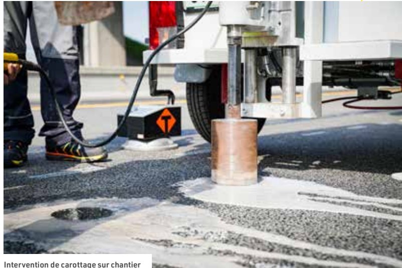
Intervention de carottage sur chantier
