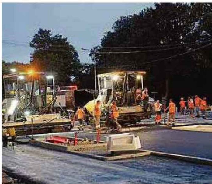
Travaux publics réalisés par le spécialiste du BTP Lhotellier sur le chantier des voies de bus d'Amiens. Photo DR
