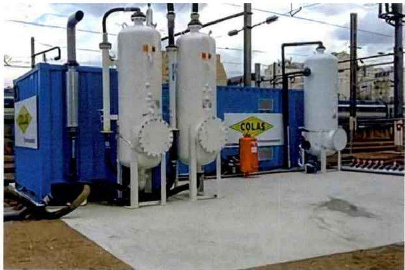
Traitement de surnageant par E2S, Extraction Séquencée de Surnageant, technique brevetée par Colas Environnement et traitement de la ZNS par bioventing. Réalisation Colas Environnement.
