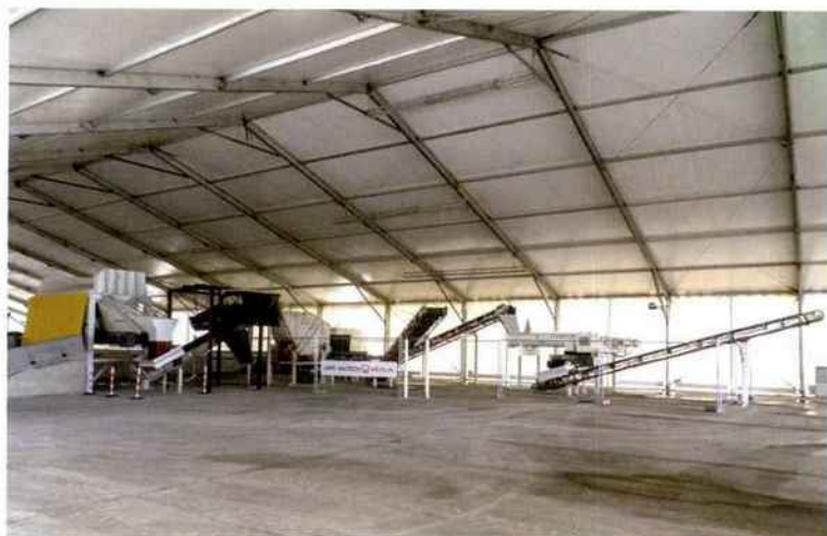
Installation de prétraitement sous tente permettant d'optimiser en amont l'ensemble des phases de traitement. Chantier GRS Valtech.
