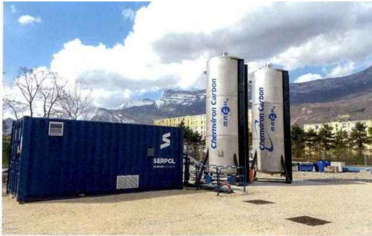
Traitement par sparging/venting des eaux souterraines impactées par des solvants chlorés et pesticides issus d'une ancienne décharge. Réalisation Serpol.
