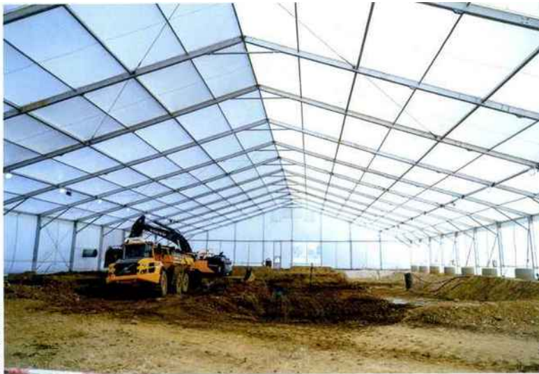
Deux tentes de confinement de 9.000 m 2 ont été construites par Suez Remediation sur un site de l'industrie chimique fortement pollué par des hydrocarbures, solvants chlorés et des métaux datant des années 1950 pour limiter au maximum les nuisances olfactives et prétraiter les sols et les nappes par venting et sparging.
