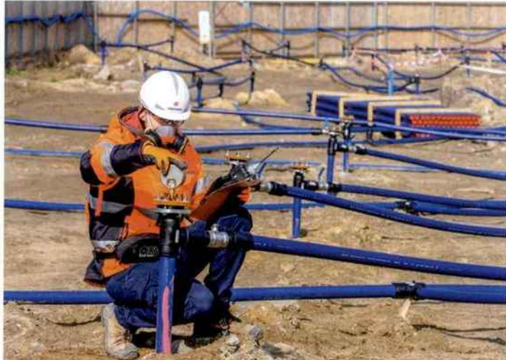
Prétraitement par venting en vue de réduire le volume de COV emprisonnés dans la porosité du sol d'un chantier en Pologne. Réalisation Remea.
