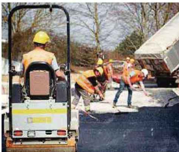
Des engins appelés « malaxeuses » pulvérisent l'ancienne chaussée pour reconstituer instantanément une nouvelle route issue des matériaux recyclés. Lhotellier
