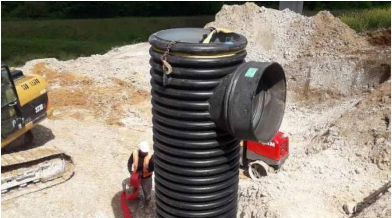
**Dans le cadre du chantier de prolongement de la RN27, à Dieppe, des tubes annelés Flowrain de Polieco France ont été installés. Leur mission est de canaliser et véhiculer les eaux pluviales récupérées sur cette nouvelle route.**
