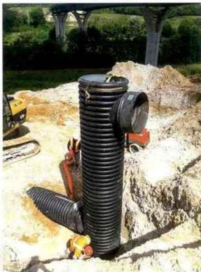
Grâce à son atelier de chaudronnerie plastique installé dans l'usine de Feillens, Polieco France a pu proposer à l'entreprise de pose une offre réseau complète avec des regards de grandes dimensions, tous réalisés sur mesure.
