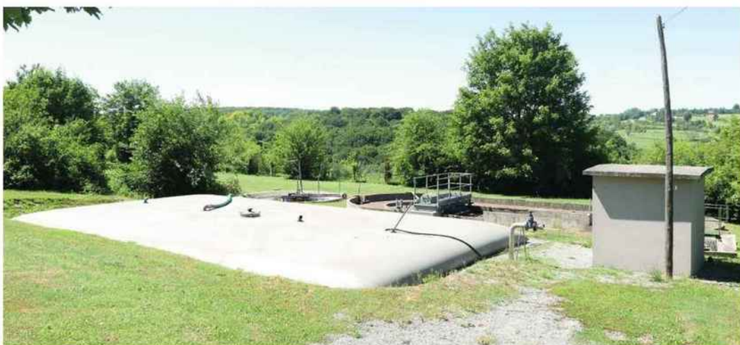
Elle devait être réhabilitée, mais la station d'épuration de Lahaye-Saint-Romain, plus aux normes, sera finalement détruite.
