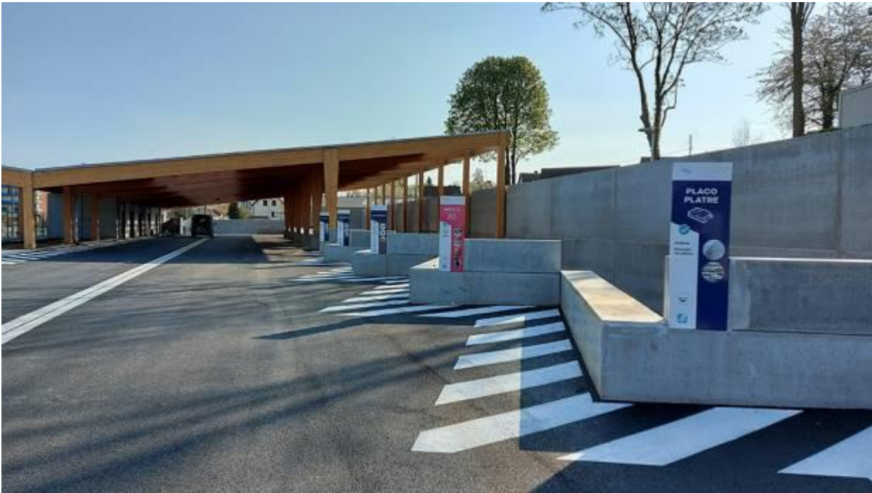
Chantier à Louviers
