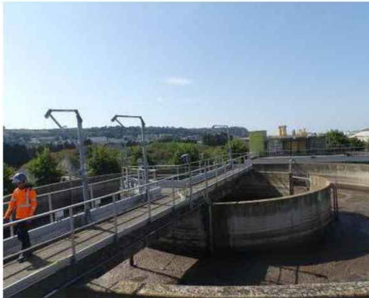
La station d'épuration du Tréport utilise des bactéries pour nettoyer les eaux usées.
