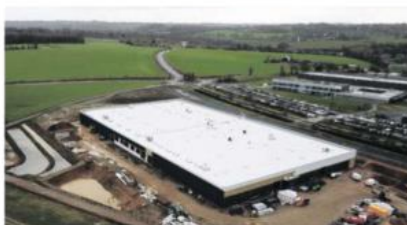
L'entreprise dispose sur son toit de 1 488 panneaux solaires.
