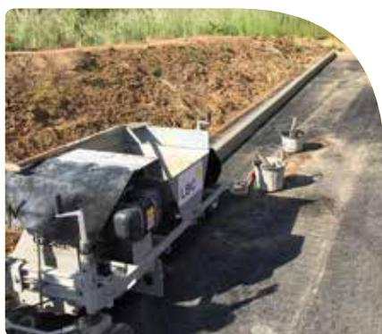
■ **PC 150- PC 200**, nos PC peuvent réaliser des bordures uniquement sur GB ou enrobé fini, bordures îlots et des murets avec une hauteur maximum de 45 centimètres, guide roue.
