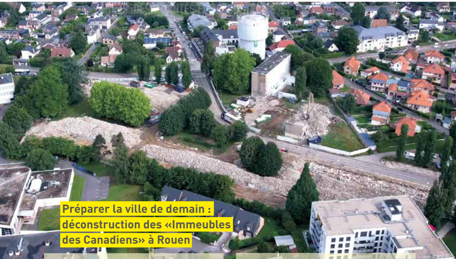
Chantier «Les Canadiens» - Rouen (76)
