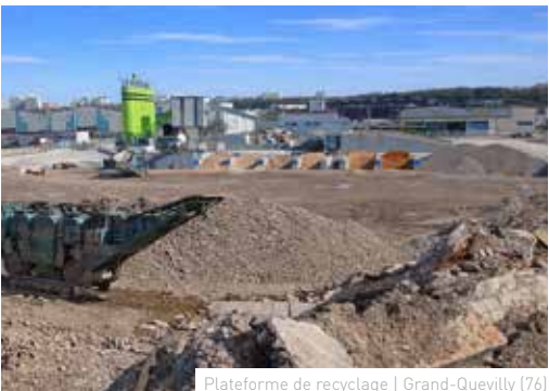
Plateforme de recyclage | Grand-Quevilly (76)
