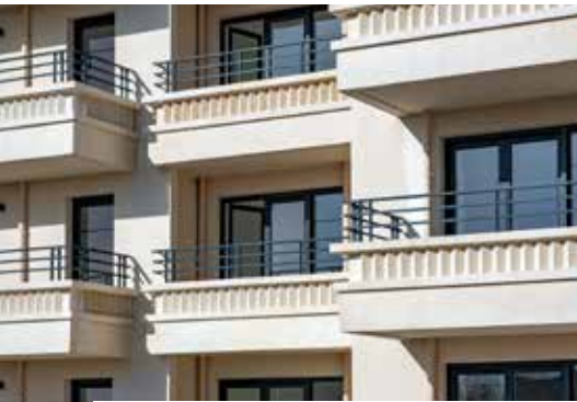
Éléments de façade préfabriqués | Saint-Ouen-sur-Seine (93)
