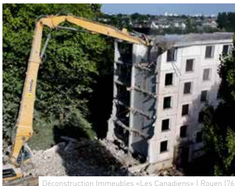
Déconstruction Immeubles «Les Canadiens» | Rouen (76)
