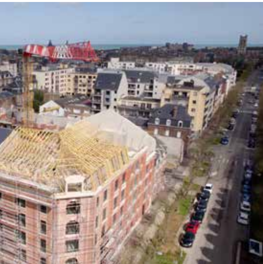
Îlot Pasteur - construction de logements collectifs | Dieppe (76)
