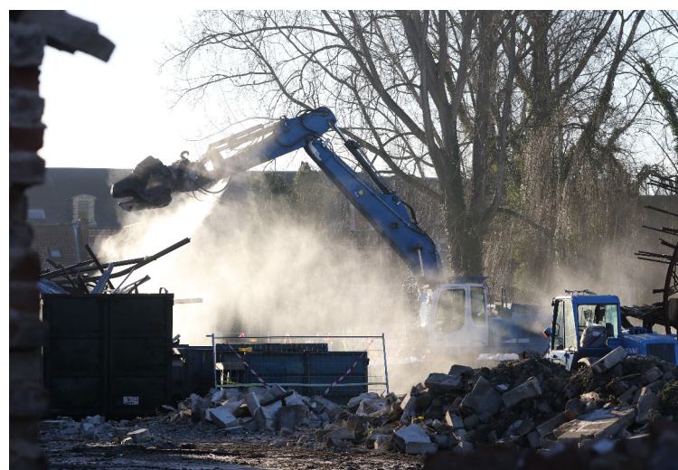
Ces jours-ci, les pelles mettent au sol les bâtiments situés à gauche de l'entrée principale (depuis la rue Léon-Cure). C'est sur cette zone que le futur Lidl va voir le jour dans les mois à venir.
