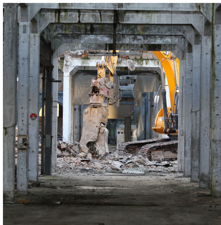
La technique de démolition par explosif aurait pu être utilisée mais elle est très coûteuse. Ici, les bâtiments sont grignotés petit à petit par une pelle équipée de pinces spéciales.
