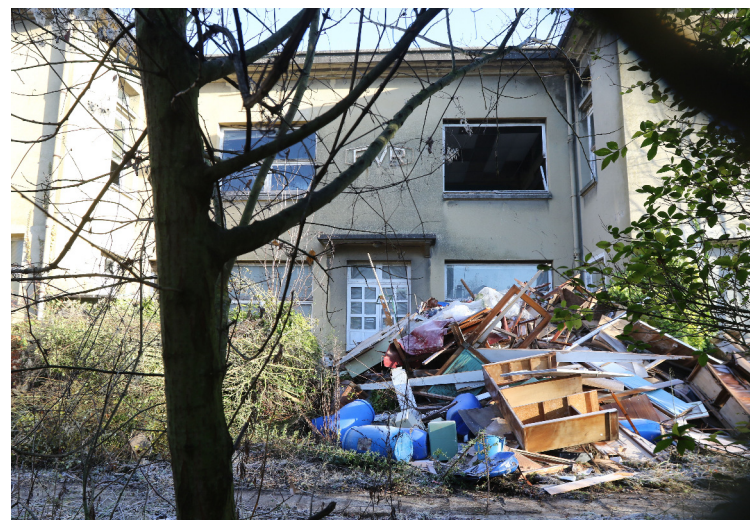
L'édifice situé à l'entrée de l'ancienne friche et qui abritait le service administratif vit ses derniers jours. Hier, mercredi, les ouvriers le préparaient pour l'étape de désamiantage. Il sera ensuite abattu.
